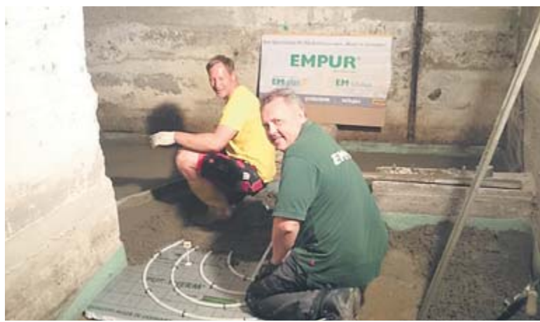
Ronny Kautsch (vorn) von der Firma EM-Solution und Rene Schäffler vom Estrichhersteller Unger-Bausysteme aus Chemnitz beim Verlegen von Fußbodenheizung und Estrich in der Proraer Anlage.
